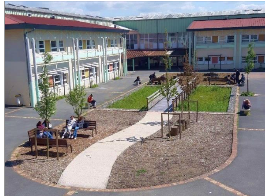
Travaux VRD en juillet et plantations en octobre 2023
