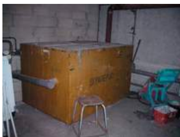
◀ Bac à graisse de 5m 3 vidangé 6 fois par an
