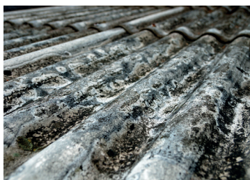
► Toiture en fibrociment
