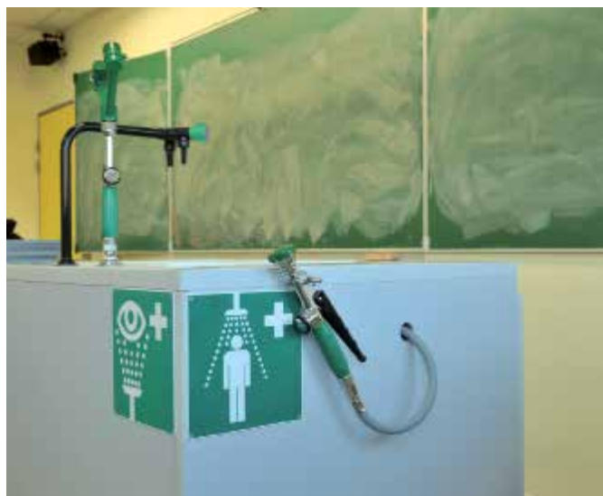
Équipements de premiers secours, les douches et laveurs d'yeux doivent être installés à proximité des zones de danger, salles de travaux pratiques, salles de préparation et de stockage de produits chimiques...
